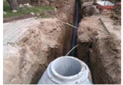
Karalar Beldesi Ek Kanalizasyon Yapım İşi
