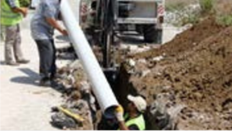
İdil Merkez Kanalizasyon Yapım İşi
