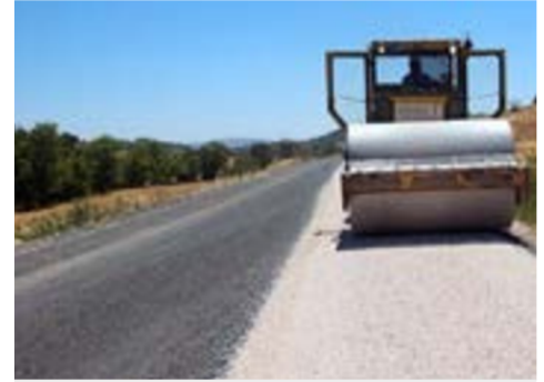
Karalar Belediyesi Yol Yapım İşi
