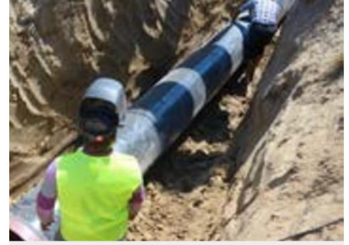
Pınarbaşı Köyü İçme Suyu Yapım İşi
