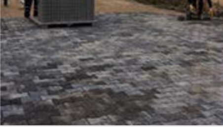
Siirt Baykan İlçesi Veysel Karanî Beldesi Parke Taşı Döşeme İşi
