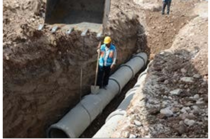
İlbank Erzincan Altınbaşak Beldesi Kanalizasyon Yapım İşı
