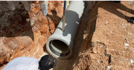
Şanlıurfa Su Kanal İdaresi Halfeti İlçesi Yukarı Göklü Kanal Yapım İşi
