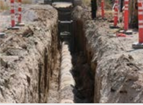
Şırnak Merkez Kanalizasyon Şebeke Yapım İşi
